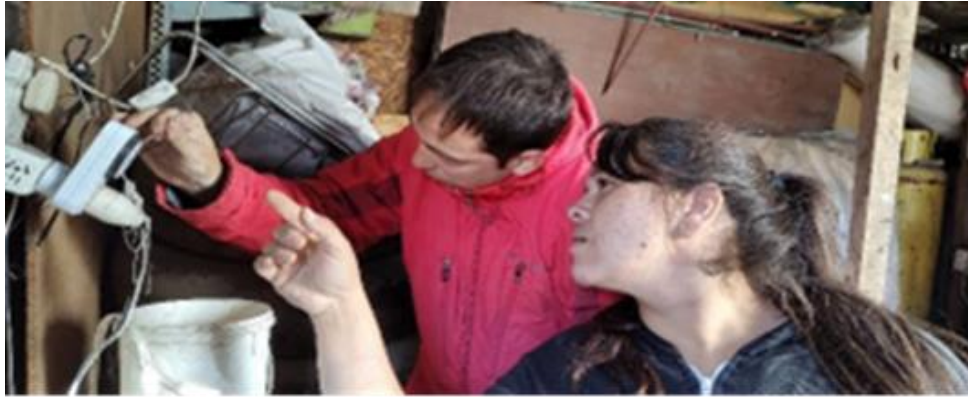
Foto 10. Instalación y calibración de temporizador en La Porfiada
